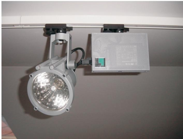
Strahler zur Grundbeleuchtung mit separatem, elektronischem, steckerfertigem Vorschaltgerät.
